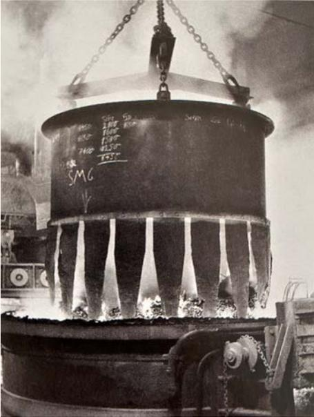
Abbildung 4: Eine Ladung Schrott wird in den Schmelzofen entleert, 1940
